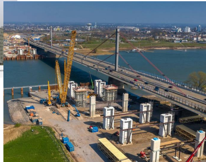
Quelle: WDR, „Stauende in Sicht“, Rheinbrücke Leverkusen“, 5. Sept. 2023
